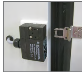
Elektromechaniczne rygłowanie drzwi, sterowane programowo i/lub ręcznie
