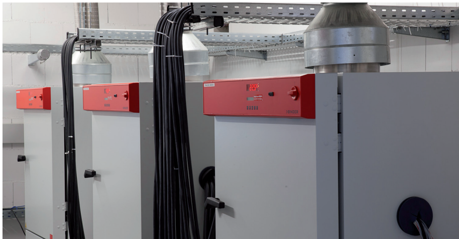
› Puertos de acceso especiales para el cableado y tapas de sobrepresión calefactadas
