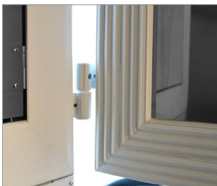
Ausgeschäumte Kompartimenttüren mit Dichtung
