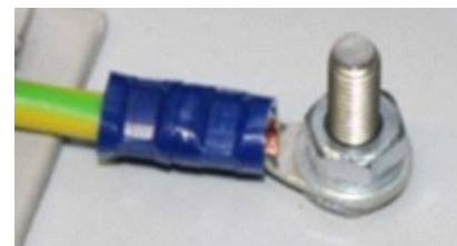
Abbildung 23: Erdungsanschluss (9) (Lieferzustand) zur Anbringung eines Potenzialausgleichskabels
