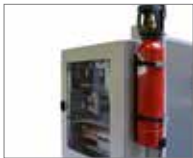
CO 2 -Feuerunterdrückungseinrichtung
