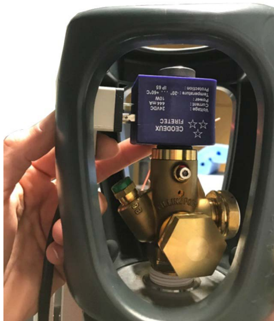
Abbildung 32: Anschluss des Spulensteckers
